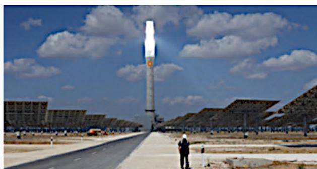
140 m. Elle dispose d'un stockage à sels fondus de 15 h permettant de fonctionner 24h/24 en été et de produire 110 GWh par an (soit la consommation de 25 000 foyers). La centrale utilise 8500 tonnes de sels. 9 mois ont été nécessaires pour les fondre pendant la construction » [29].
