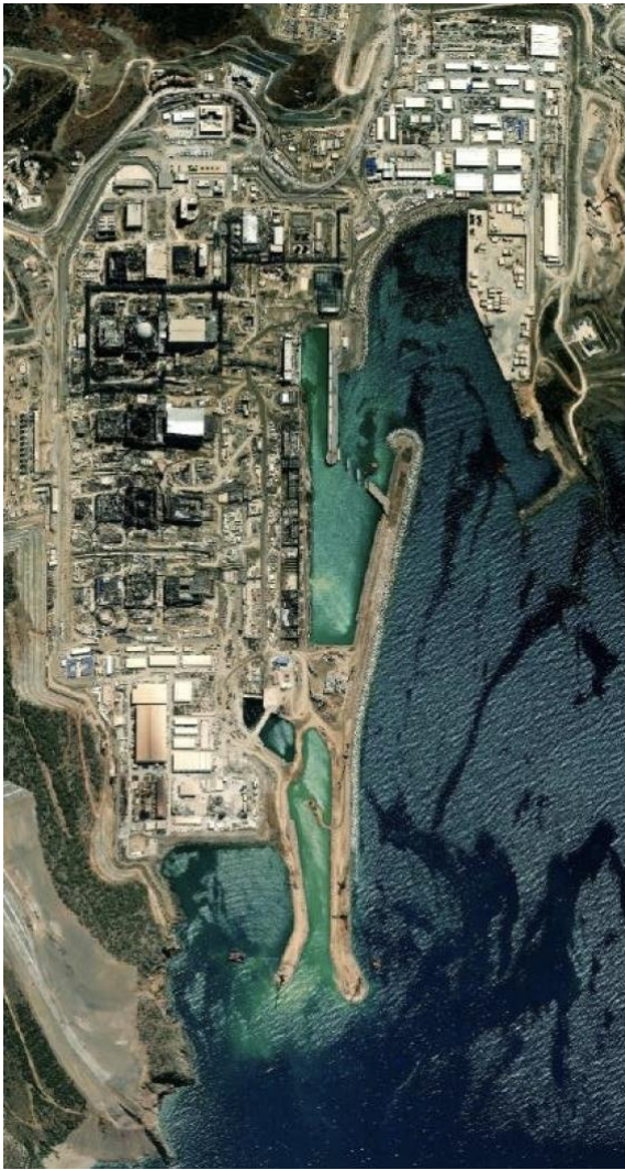
Centrale d'Akkuyu et son port
