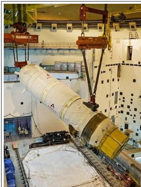
Flamanville 3 – Pressuriseur en cours de manutention (Juin 2015)
