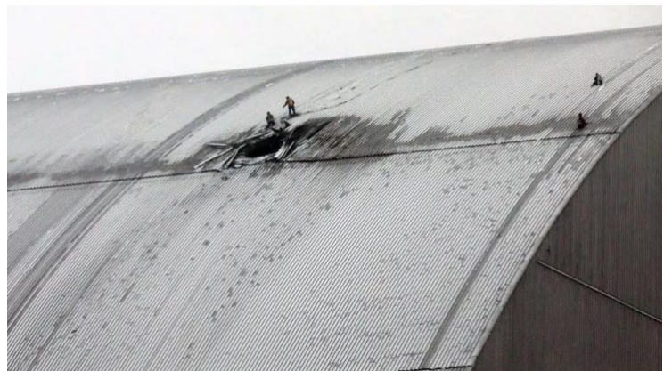
Perte d'étanchéité du second sarcophage
