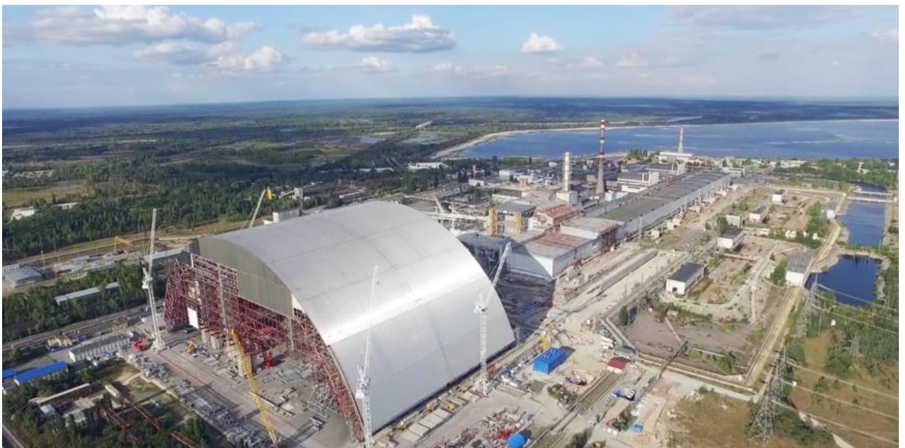
Construction du second sarcophage de la tranche n° 4 de la centrale de Tchernobyl
