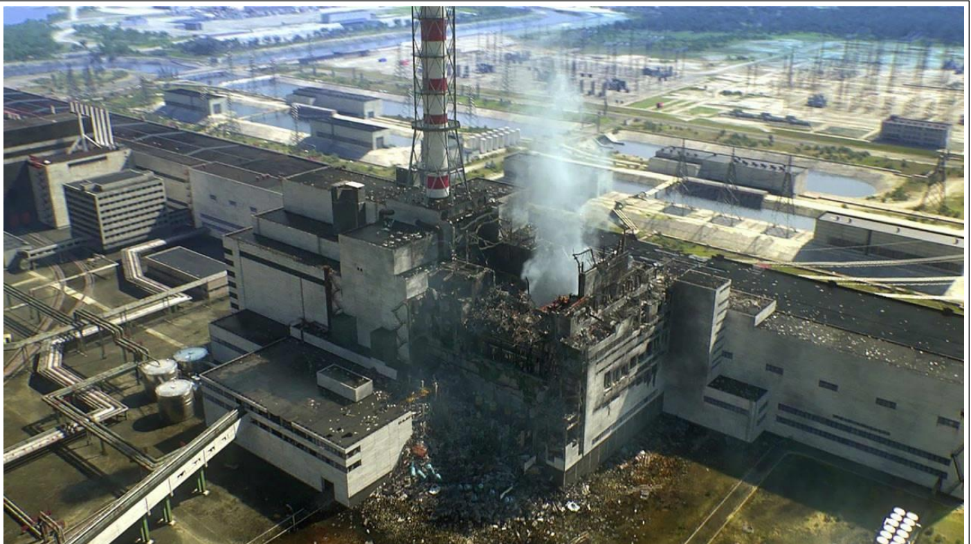
Tranche n° 4 de la centrale de Tchernobyl, 1986
