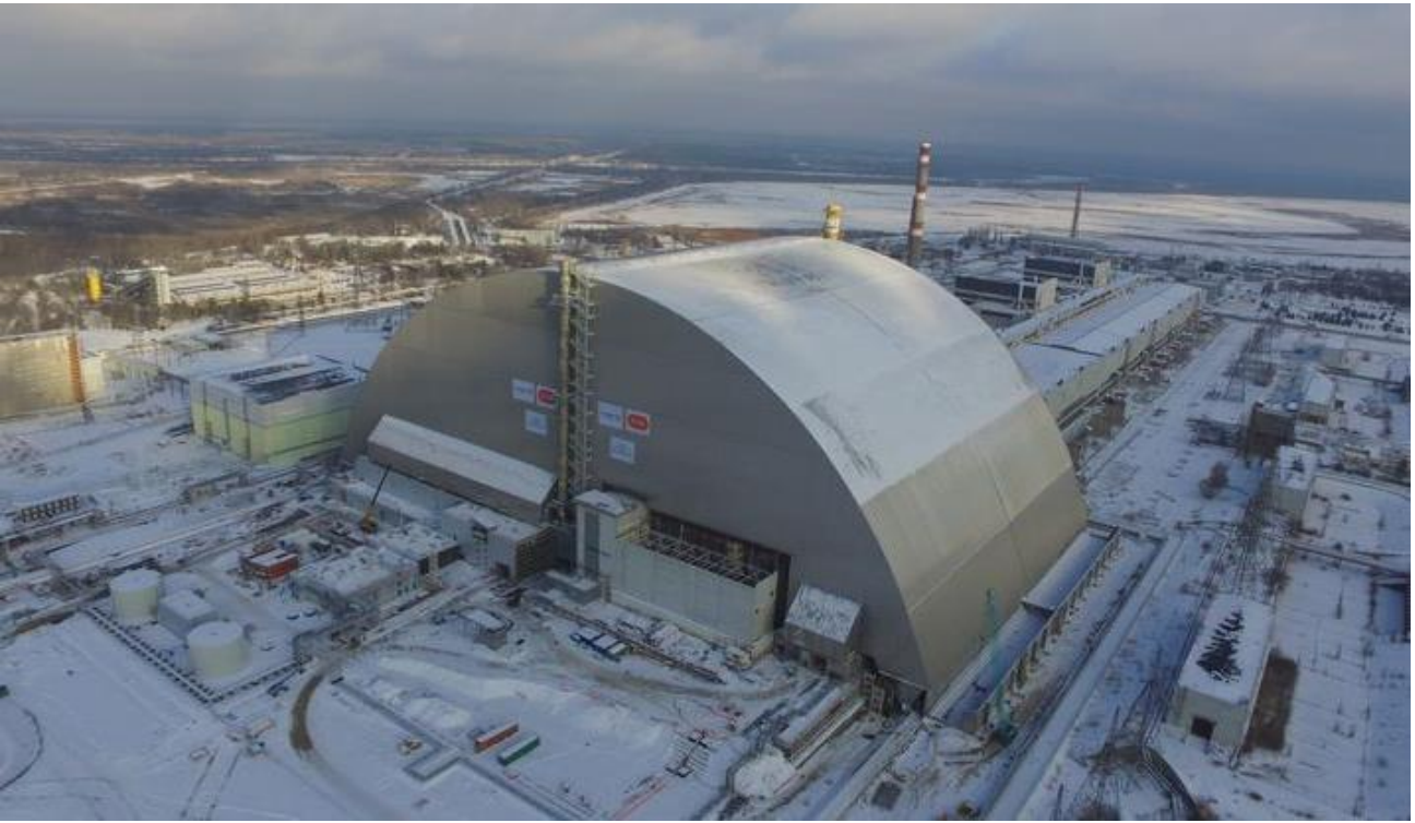
Le second sarcophage de la tranche n° 4 de la centrale de Tchernobyl est en place
