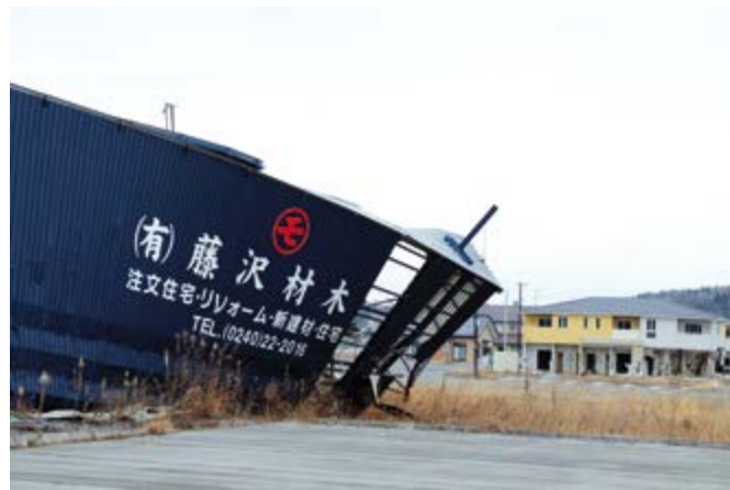
A Tomioka, un village fantôme, les dégâts du tremblement de terre survenu il y a 6 ans sont encore visibles.
